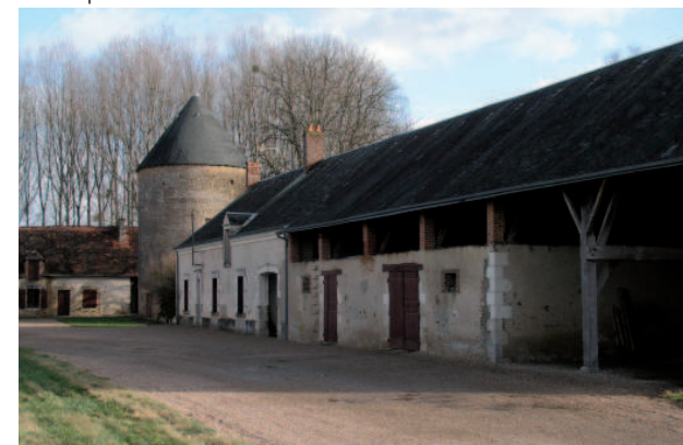
Vue des bâtiments au sud de la cour et de la tour
