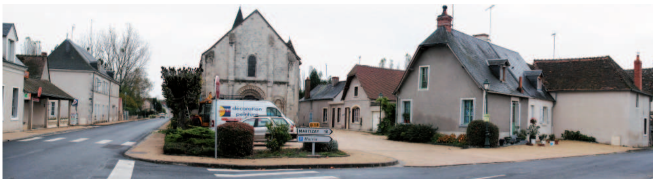
Vue de la place Saint-Etienne : une séquence bâtie alternant constructions anciennes et espaces publics
