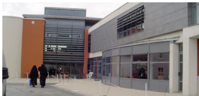
Vue de la maison de retraite, dont l'architecture et les matériaux sont en forte dissonance avec les formes urbaines anciennes
