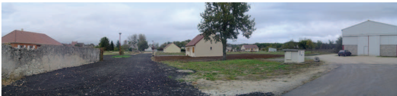
Opération de maisons individuelles particulièrement critique au niveau de son insertion urbaine : absence de traitement des limites séparatives à l'intérieur de l'opération, et avec le tissu ancien du bourg et la zone d'activité. Une «zone» qui met en péril la qualité du bourg de Saint-Michel-en-Brenne
