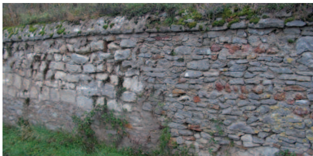
Muret de pierres calcaires et de grès rouge
