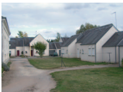
Opération de maisons en bande à l'entrée du bourg
