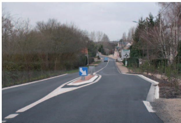
Exemple d'entrée de bourg aménagée à Paulnay
