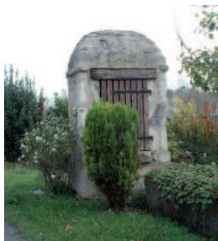
Puits de l'ancien prieuré de Notz l'Abbé, Martizay
