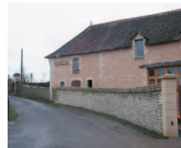
Muret et bâti réhabilité à Martizay
