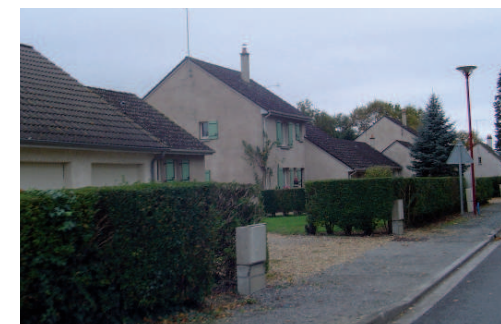
Lotissement de maisons groupées en quatre ensembles à l'entrée est du bourg de Saint-Michel-en-Brenne
