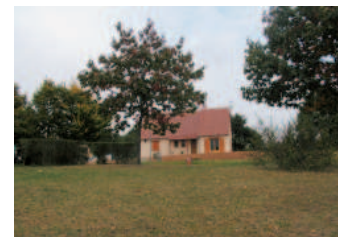
Maison individuelle implantée en surplomb par rapport à la route, Mézières-en-Brenne
