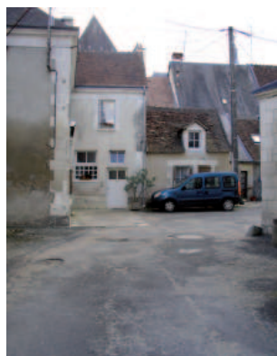
Abords dégradés de l'église
