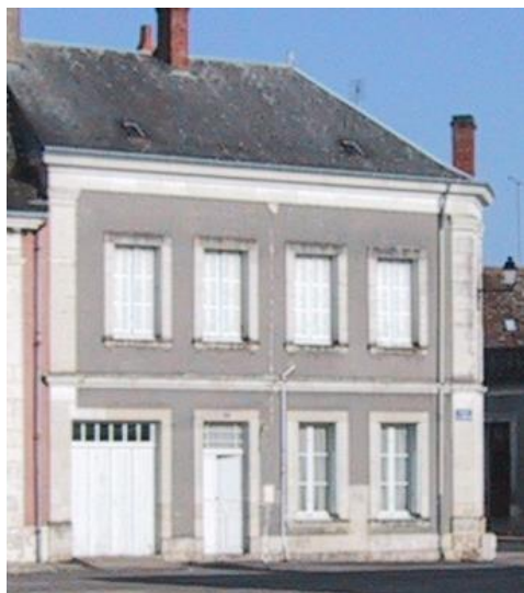
L'immeuble avant travaux
