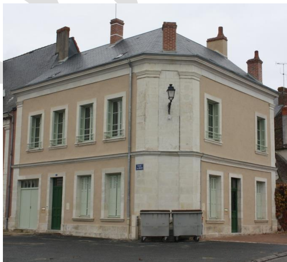
et ... Après travaux
