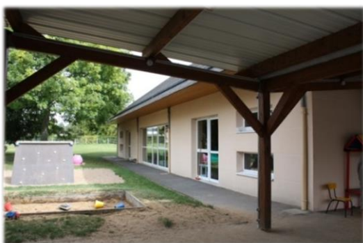
L'espace jeux avant les travaux
