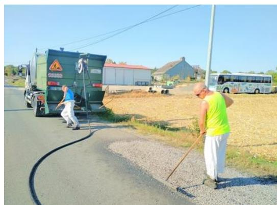
*Déflachage d'une chaussée avant mise en place d'un ECF sur Azay le Ferron*
