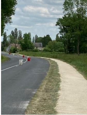
Le projet dénommé « Le Routin » consiste à établir sur les emprises des routes départementales RD 6, 15 et 17, une voie stabilisée pour permettre la circulation en toute sécurité des randonneurs hors de la chaussée.
