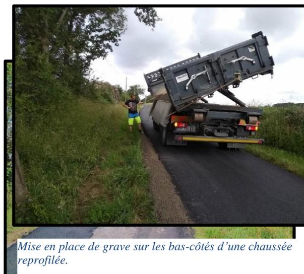
*Mise en place de grave sur les bas-côtés d'une chaussée reprofilée.*
