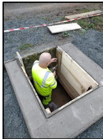
Réalisation d'un regard d'eaux pluviales
