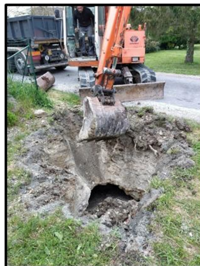
Terrassement d'une ancienne cave suite à effondrement du bas coté de la chaussée
